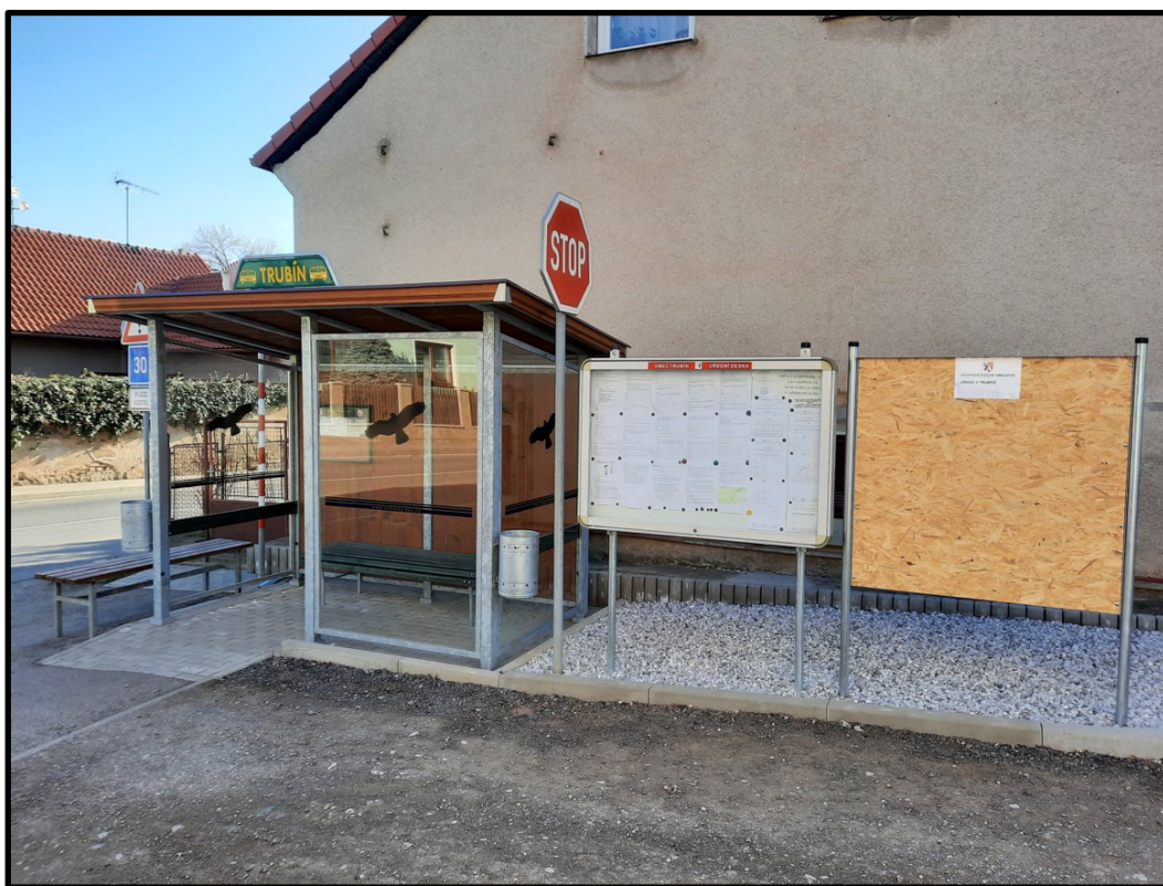
Pohled nastávající přístřešek BUS – bude zachován
